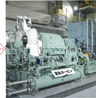
●蒸気タービン発電機 ボイラで発生した蒸気により、発電を行います。
