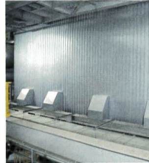
●バグフィルタ アルカリ反応剤、活性炭を吹込んで排ガス中の有害物を除去します。
