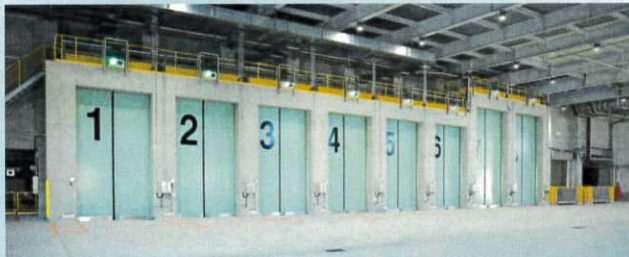
●プラットフォーム 計量したごみを受け入れ、ごみピットへ投入します。 ●Platform The weighed garbage is received here and dumped into the waste pit.
