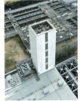
●煙突 きれいになった排ガスを煙突より大気中に放出します。
